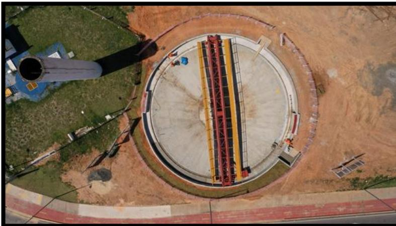
Conforme definição do DNIT, o girador é uma estrutura com movimento de rotação em torno do apoio central e que suporta um segmento de linha, usado para inverter a posição das locomotivas. O mesmo possui um diâmetro de 20m, e capacidade para um material
